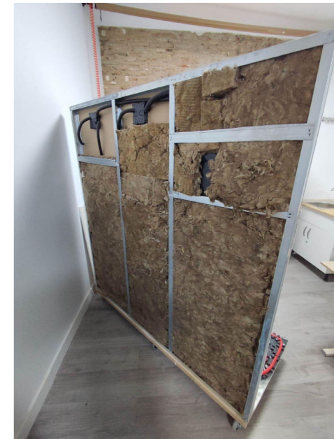
Fig 3: Vista posterior de la instalación construida, donde se puede apreciar la instalación eléctrica, así como la ejecución de la tabiquería autoportante de placas de yeso laminado con aislamiento en su interior.
